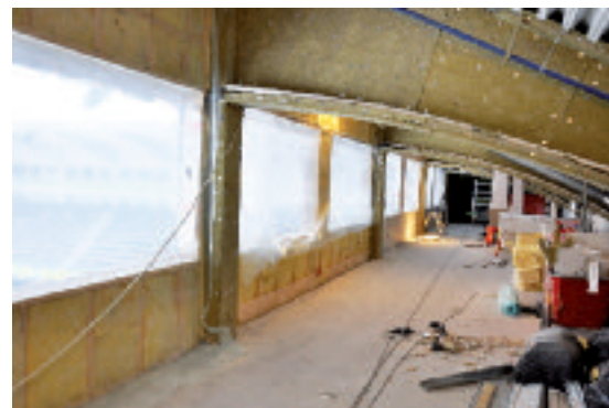
Innredningen av fjerde etasje pågår for fullt
